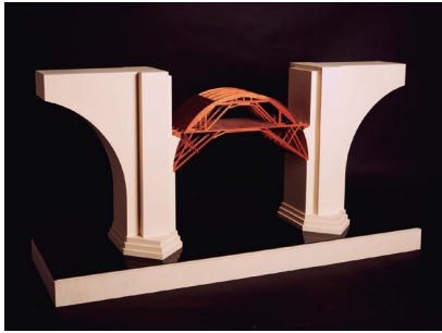
Cimbra para la construcción del puente romano de Alcántara sobre el río Tajo (Alcántara, Cáceres)
